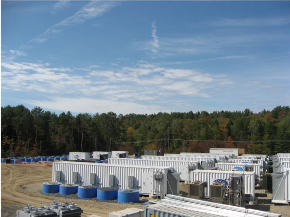
Abbildung 4.35: Weltweit erste Schwungradanlage mit 20 MW Leistung. Zu sehen ist die Anlage kurz vor der Fertigstellung [112].
