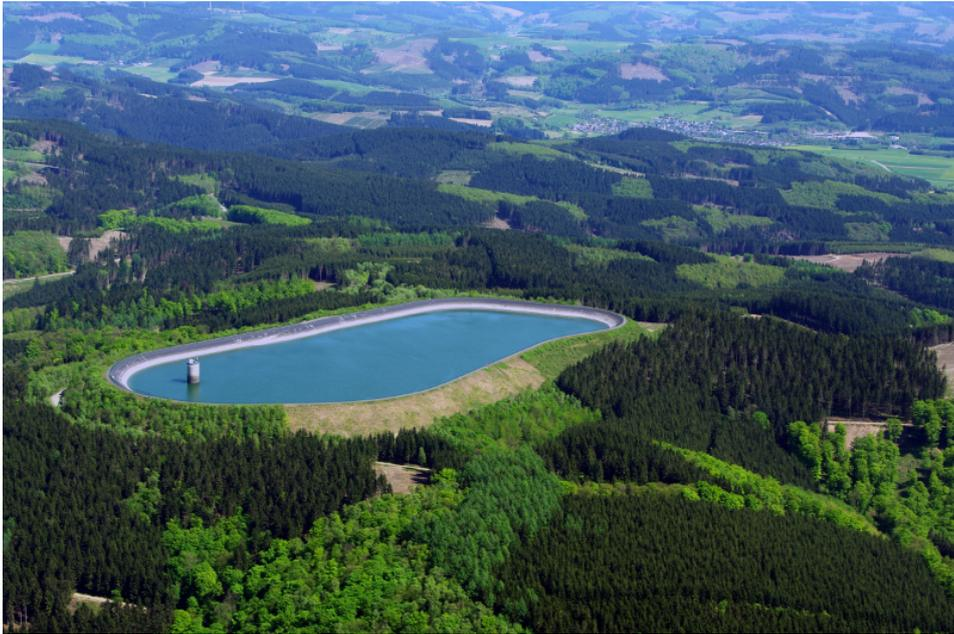
Abbildung 4.33: Künstlich angelegtes Oberbecken des Pumpspeicherkraftwerks Rönkhausen. 140 MW Leistung, 690 MWh Kapazität [106].
